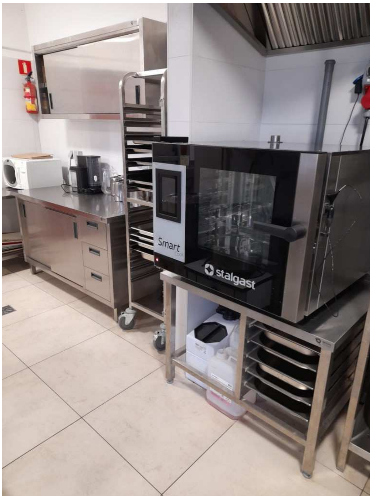
Zdjęcie nr 1. Przedszkole Miejskie nr 6 wyremontowana kuchnia
